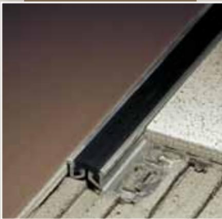
Ohne Benutzung **der Dehnfugenprofile** kann der Belag grösserer Räume bald voll von Rissen und Buckeln sein. Wegen der Wärmeausdehnung besteht bei Keramik-Belägen eine grosse Bruchschadengefahr, die aber mit Verwendung und Einbau der Dehnfugenprofile vermeidbar ist.
